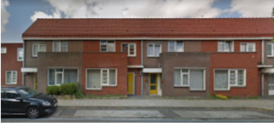
Wel en niet gerenoveerde gevels in Bornholm.
