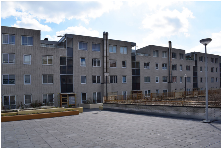
Fig. 11. Achterzijde van de woningen, gezien vanuit het woondek (TUD, 2021).
