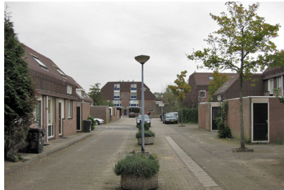
Fig. De oorspronkelijke toestand met daken met golfplaten (NAP).
