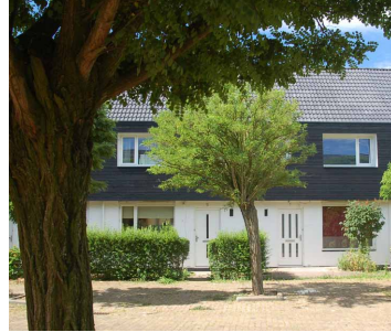
Fig. De gerenoveerde gevel met houten delen, witgeschilderd metselwerk en zelfgekozen voordeuren (Heren 5).
