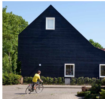
Fig. De houten gevels verwijzen naar de boerschuren in het buitengebied van Zwolle (Heren 5).
