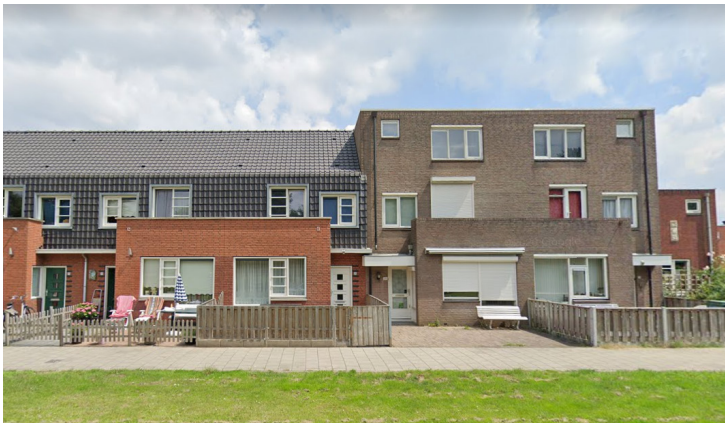
Fig. Aansluiting van gerenoveerde op niet-gerenoveerde woningen bij reguliere rijwoningen, achterzijde (Google Streetview).
