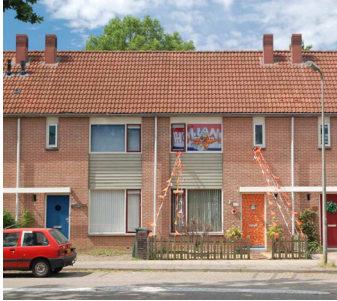
Fig. De oorspronkelijke repeterende gevel (Heren 5).
