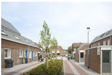
Fig. De nieuwe toestand met opgemetselde gevels en daken met dakpannen (NAP).
