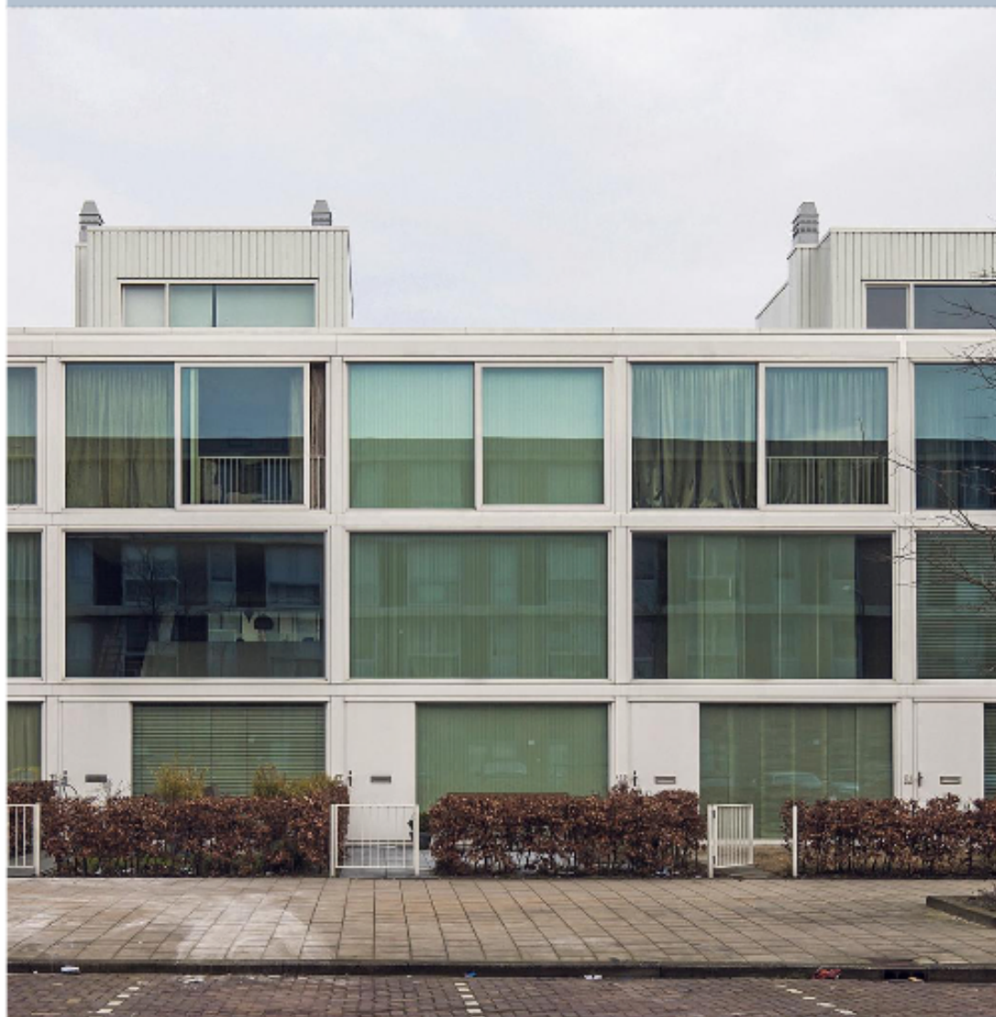
Domela Nieuwenhuisstraat, Amsterdam Nieuw-West
