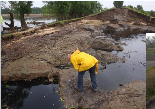
Abbildung 19: Situation am 25.06.2013, Bruchstelle, Detail Wurzelreste
