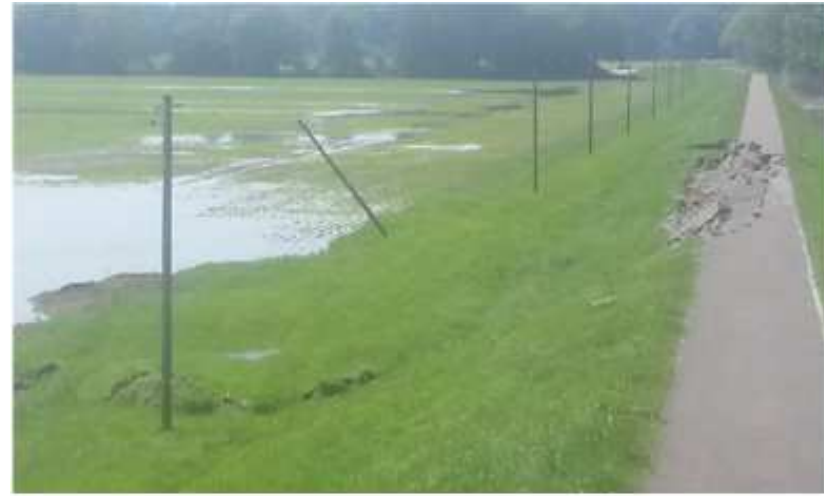
Abbildung 9: 08.06.13 – 14:10 Uhr, Horizontalverschiebungen, Aufwölbung am Fuß
