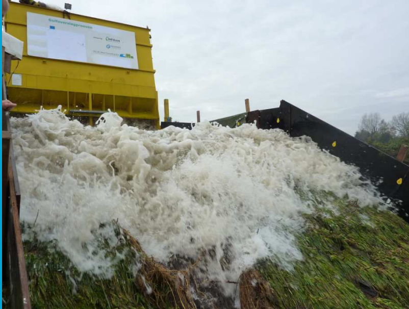
Schade bij een gemiddeld overslagdebiet van 25 l/m/s
