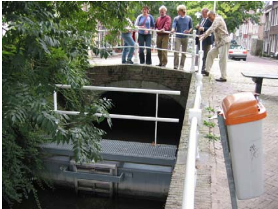
Figuur 6.3: Tijdelijke afsluitconstructie bij de Schie
