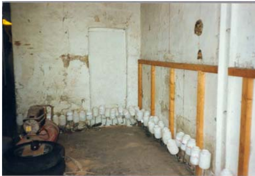
Figuur 3.16: Injecteren van muur onder hydrostatische druk
