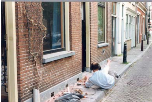
Figuur 3.18: Ventilatieopeningen in de voorgevel van de woning
