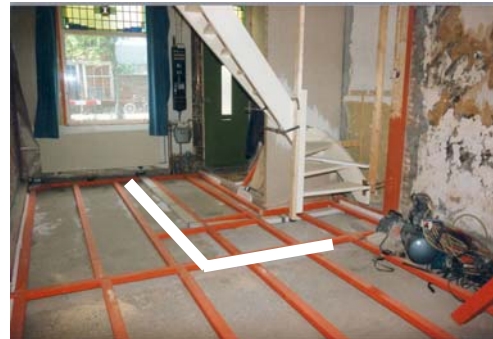
Figuur 3.19: Aanleg van vloerventilatie
