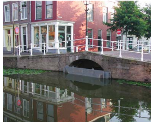
Figuur 6.4: Tijdelijke afsluitconstructie Rietveld
