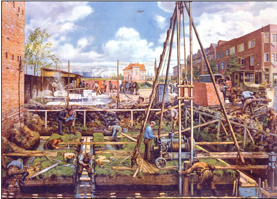
Figuur 2-3 De nieuwe straat in aanbouw (Bron: http://www.wereldorientatie.net/html/schoolplaten/ )
