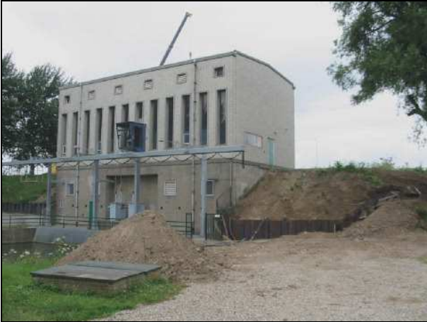
Figuur 3.8. Het Kuyjkgemaal bij de Lek.
