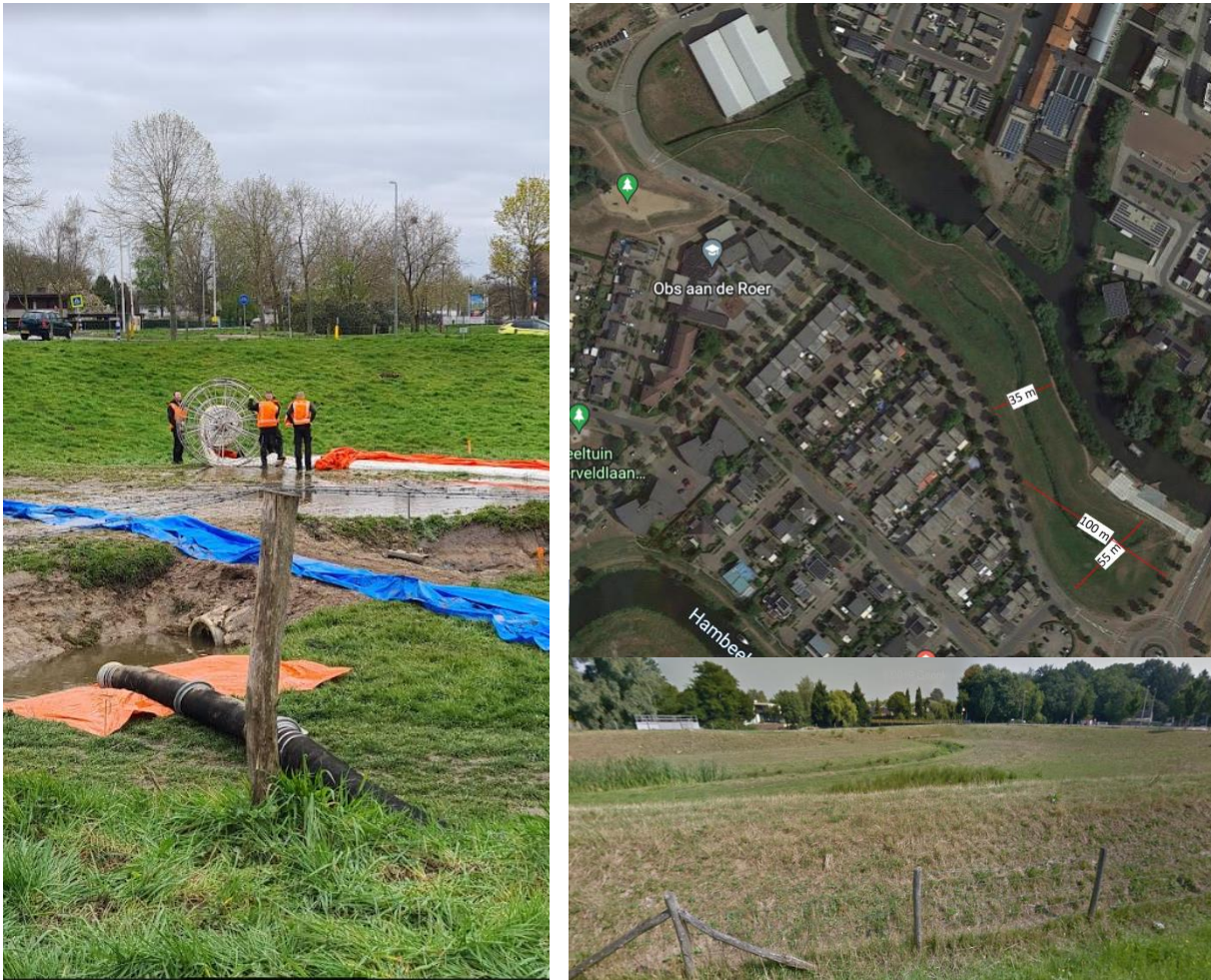
Figuur 7: Links: de duiker in de Groene Rivier, waarmee in gesloten toestand een bassin gevormd kan worden (archief TU Delft). Rechtsboven: Luchtfoto van de field-lab locatie (Google Maps, 2022). Rechtsonder: Overzichtsfoto vanaf de grond (Google Streetview, 2016).
