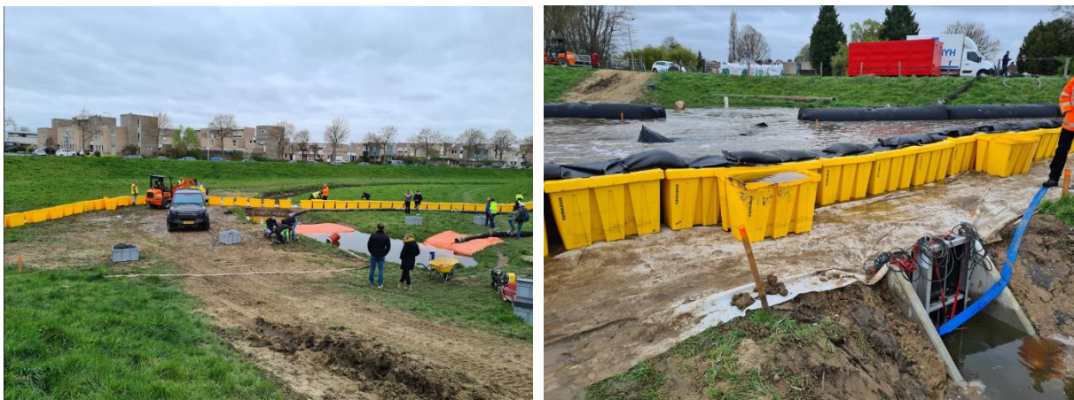
Figuur 3: De BoxBarrier met en zonder aanvullende maatregelen.
