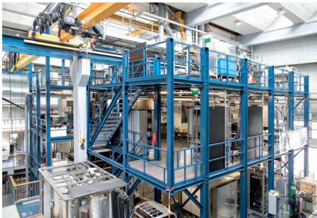
Het frame van de afdeling Process & Energy van de TU Delft geeft ruimte voor onderzoek aan relatief grote procesapparaten.
