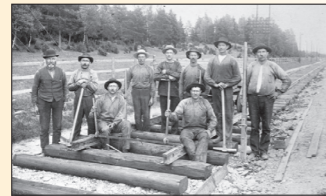
Navvies (Navigational Engineers) aan het werk aan de spoorweg tussen Stockholm en Uppsala, Zweden. Wikimedia Commons
