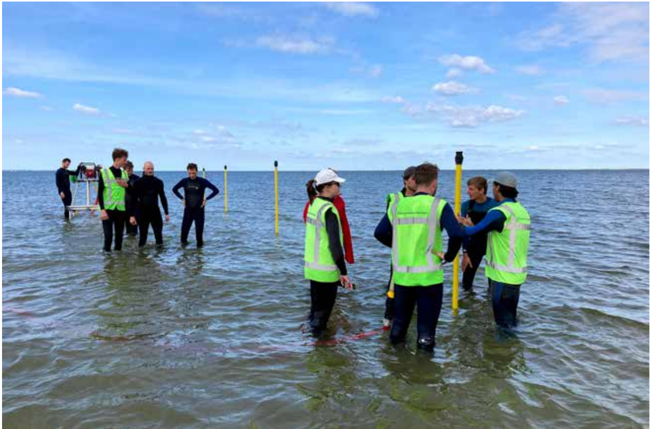
De installatie van jetpalen. Op de palen komt de acoustic doppler velocimeter, om in de branding nauwkeurig de stroomsnelheid en golfrichting vast te kunnen stellen. (Foto: via Anne Ton)
