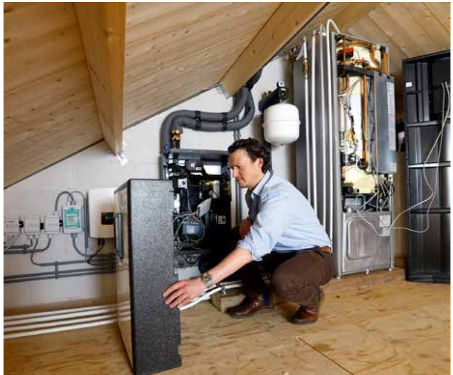
Dr. ir. Ivo Pothof bij de huisinstallatie die de PVT-panelen aan het zonnewarmtenet koppelt.
