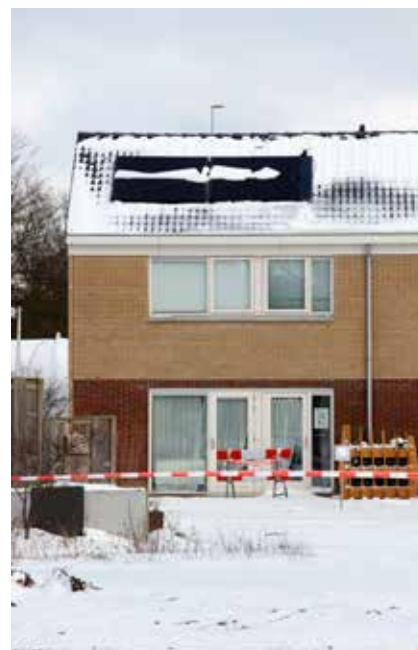
Vier PVT-panelen op dit huis in The Green Village produceren voldoende elektriciteit en warmte om het huis gasvrij te verwarmen.
