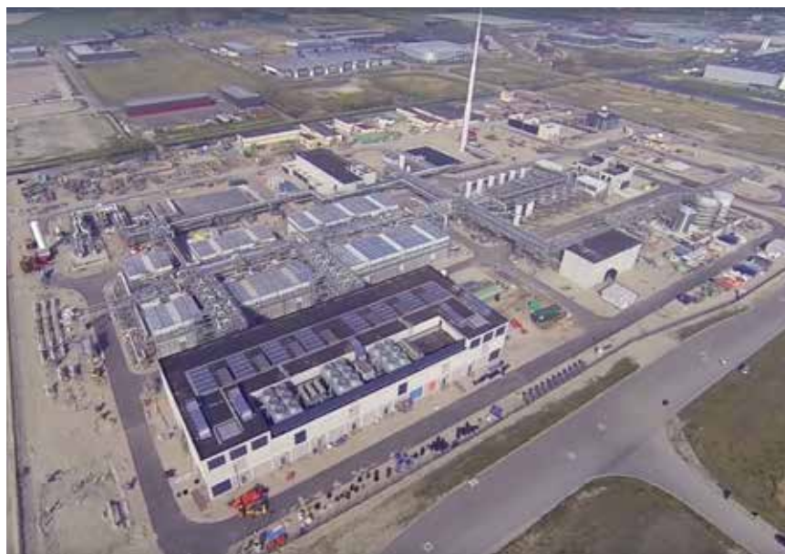
Het gasreservoir Bergemeer in Alkmaar.
