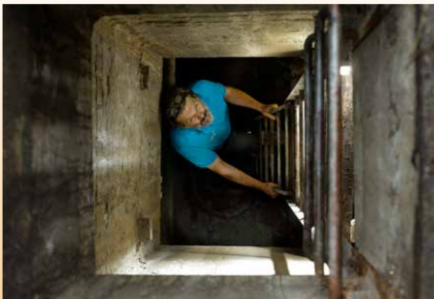
Benno Bajema inspecteert elk jaar de warmtekoker onder de campus.
