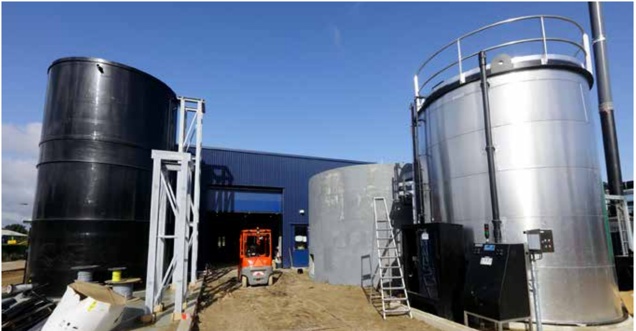
De Kaamerafabriek in aanbouw.
