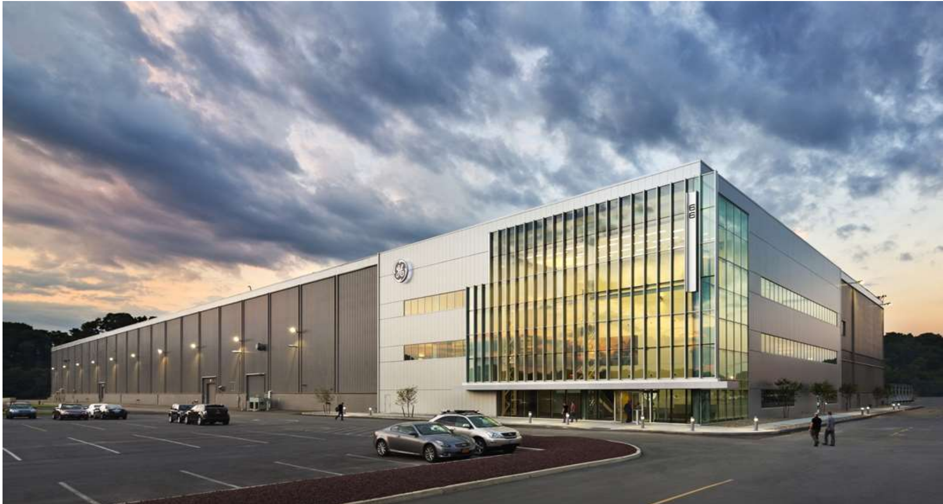
GE Plant, Bldg 66, Schenectady, NY
