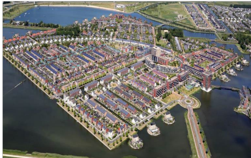
City of the Sun, Heerhugowaard, NL (4 MWp; Municipality Dijk en Waard, status 2020)
