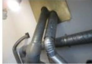
De woning wordt geventileerd d.m.v. het luchtverwarmingssysteem dat zowel lucht toevoert als afvoert. In de luchtverwarmingseenheid is een warmteterugwin unit aanwezig waar de buitenlucht wordt voorverwarmd alvorens het de hoteluchtverwarming in gaat. In de badkamer is een bediening van dit ventilatiesysteem aanwezig (met luchtvochtigheid meting).
